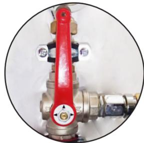
Durch die Zirkulation über die Füllstation kann bereits eingefülltes Umlaufwasser nachträglich demineralisiert werden. Es sollte ein Temperatur beständiger Filter vor die Füllstation montiert werden.
